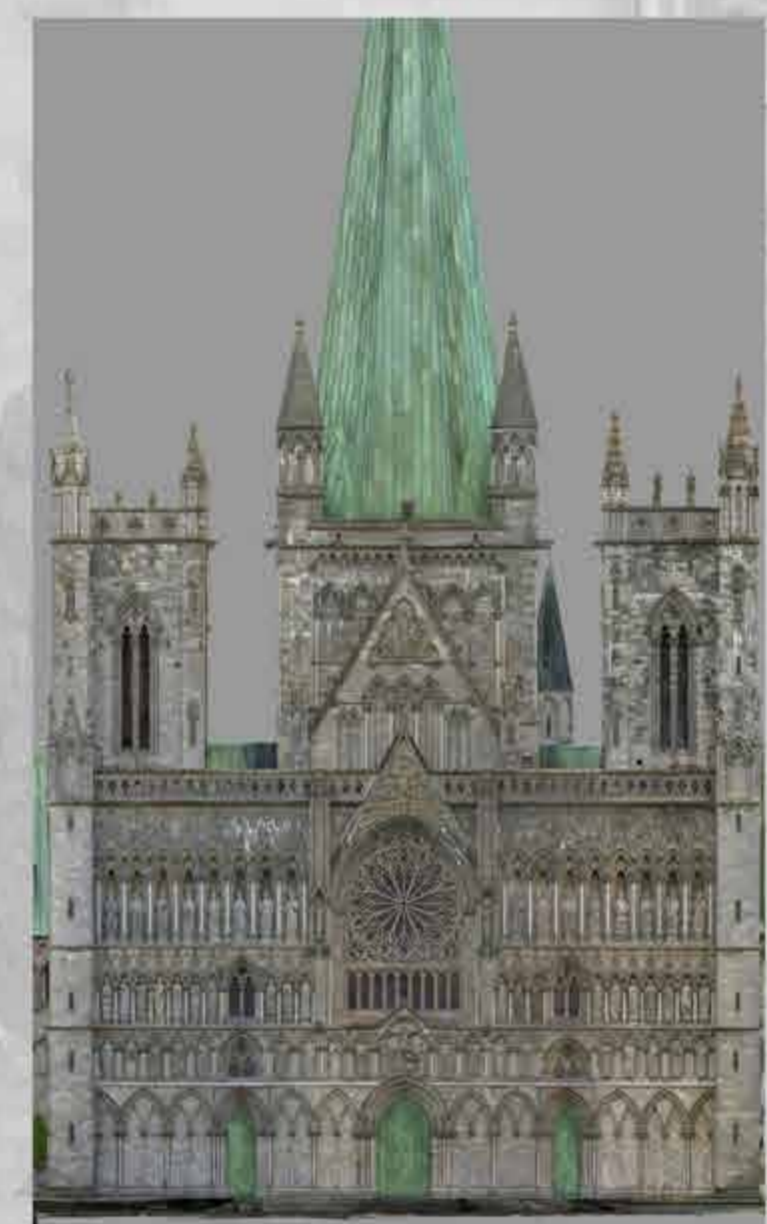
Vestfasaden med nye dører
